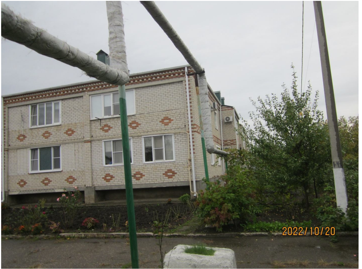
Рис. Состояние и внешний тепло трассы до потребителя. Состояние удовлетворительной.
