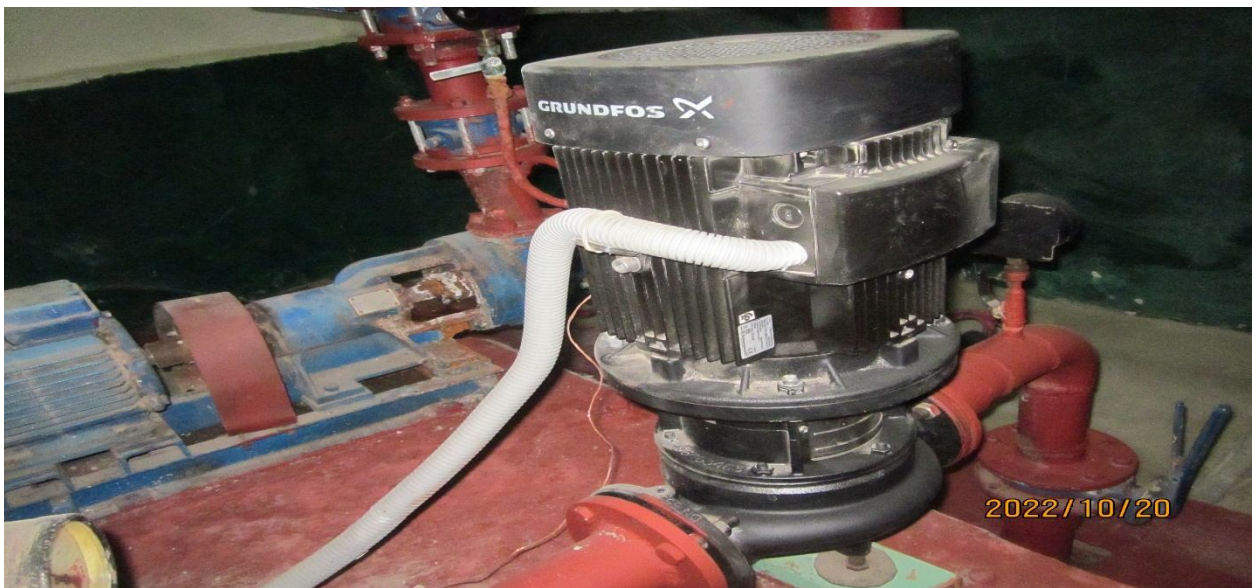
Рис Внешний вид и состояние насоса подкачки удовлетворительное
