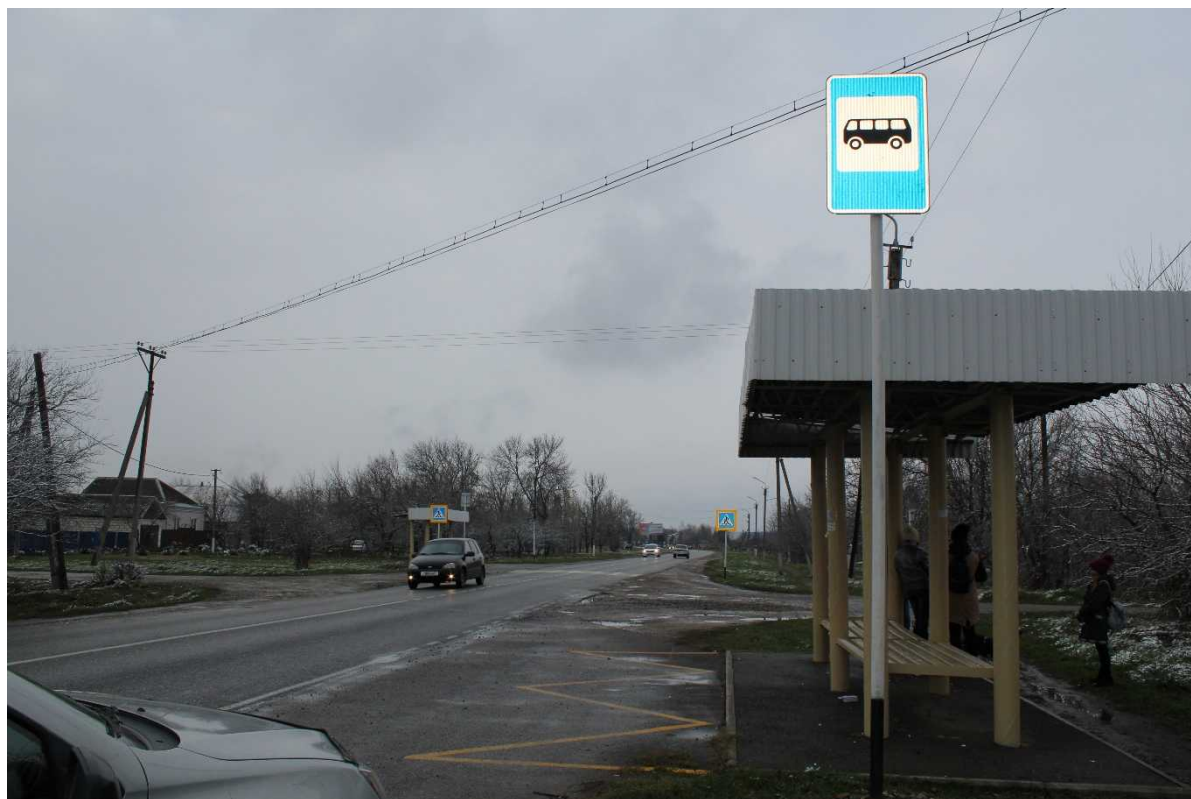
Внешний вид и состояние инфраструктуры остановки № 40
