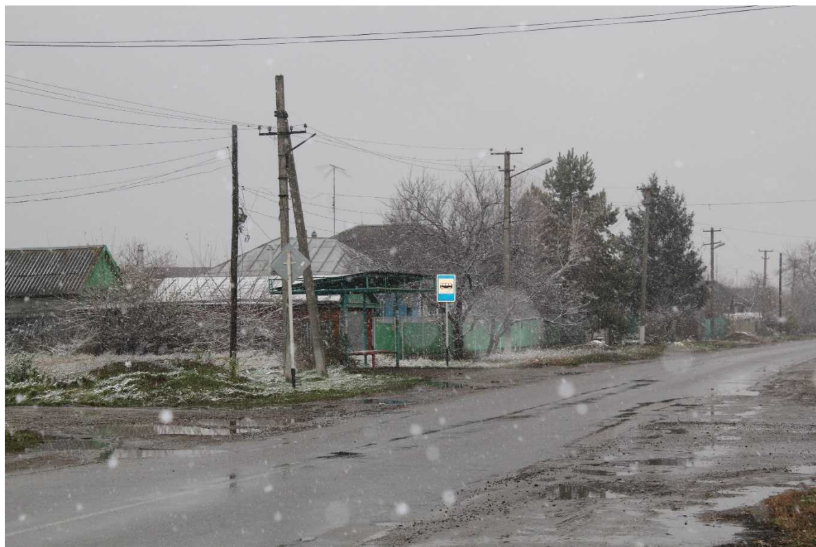
Состояние и внешний вид остановки ул.Красная_440)
