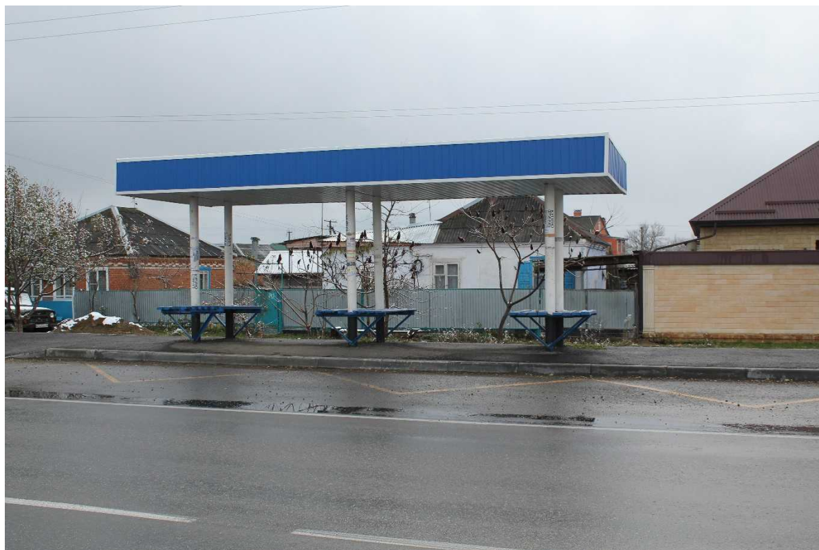
Внешний вид и состояние инфраструктуры остановки № 21
