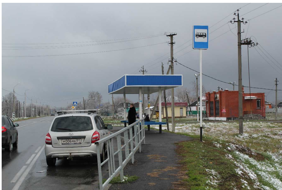
Внешний вид и состояние инфраструктуры остановки № 23
