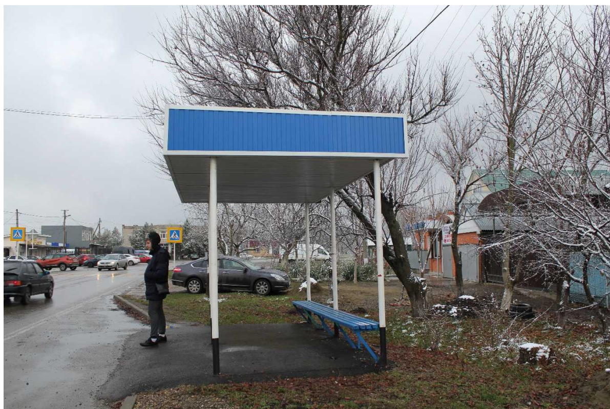
Остановка № 19. Внешний вид и состояние
