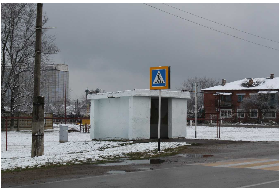
Внешний вид и состояние инфраструктуры остановки № 36
