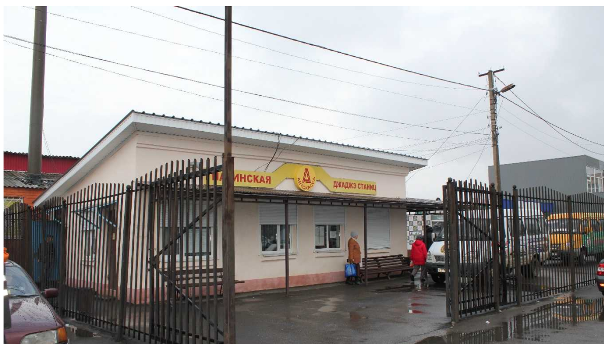
Внешний вид и состояние автостанции в станции Гиагинской
