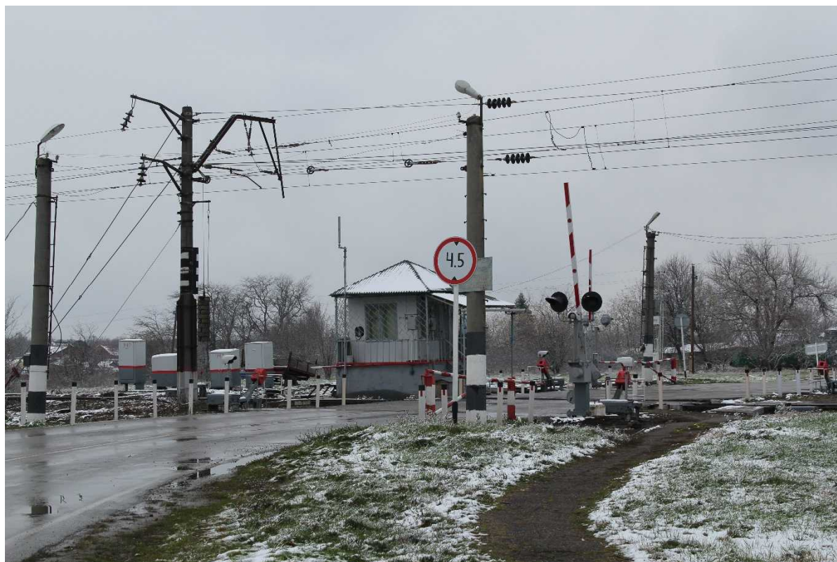
Инженерная инфраструктура железнодорожного транспорта. Переезд через железную дорогу.
