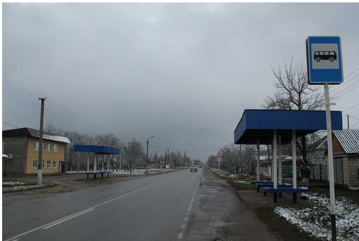
Внешний вид и состояние инфраструктуры остановки № 32
