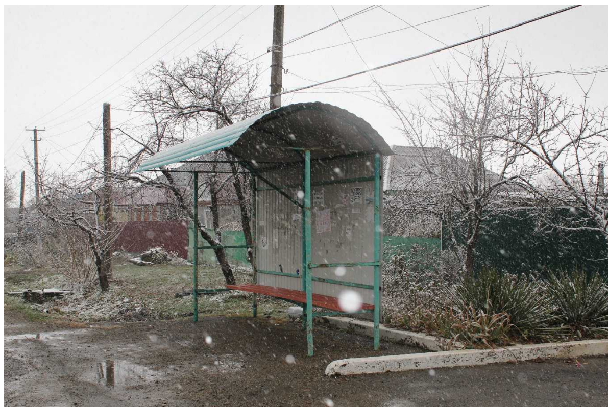
Состояние и внешний вид остановки № 07 ул.Красная_
