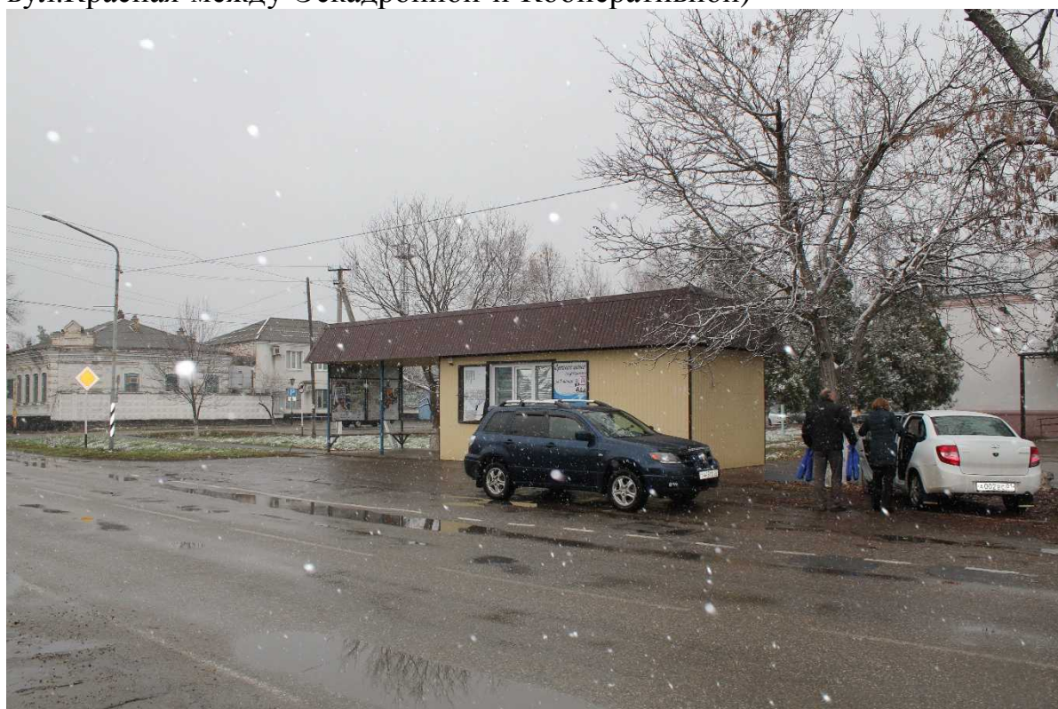
Состояние и внешний вид остановки (ул.Красная_338)
