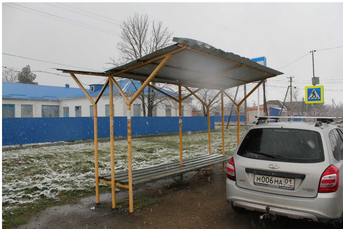
Состояние и внешний вид остановки ул.Красная_470)
