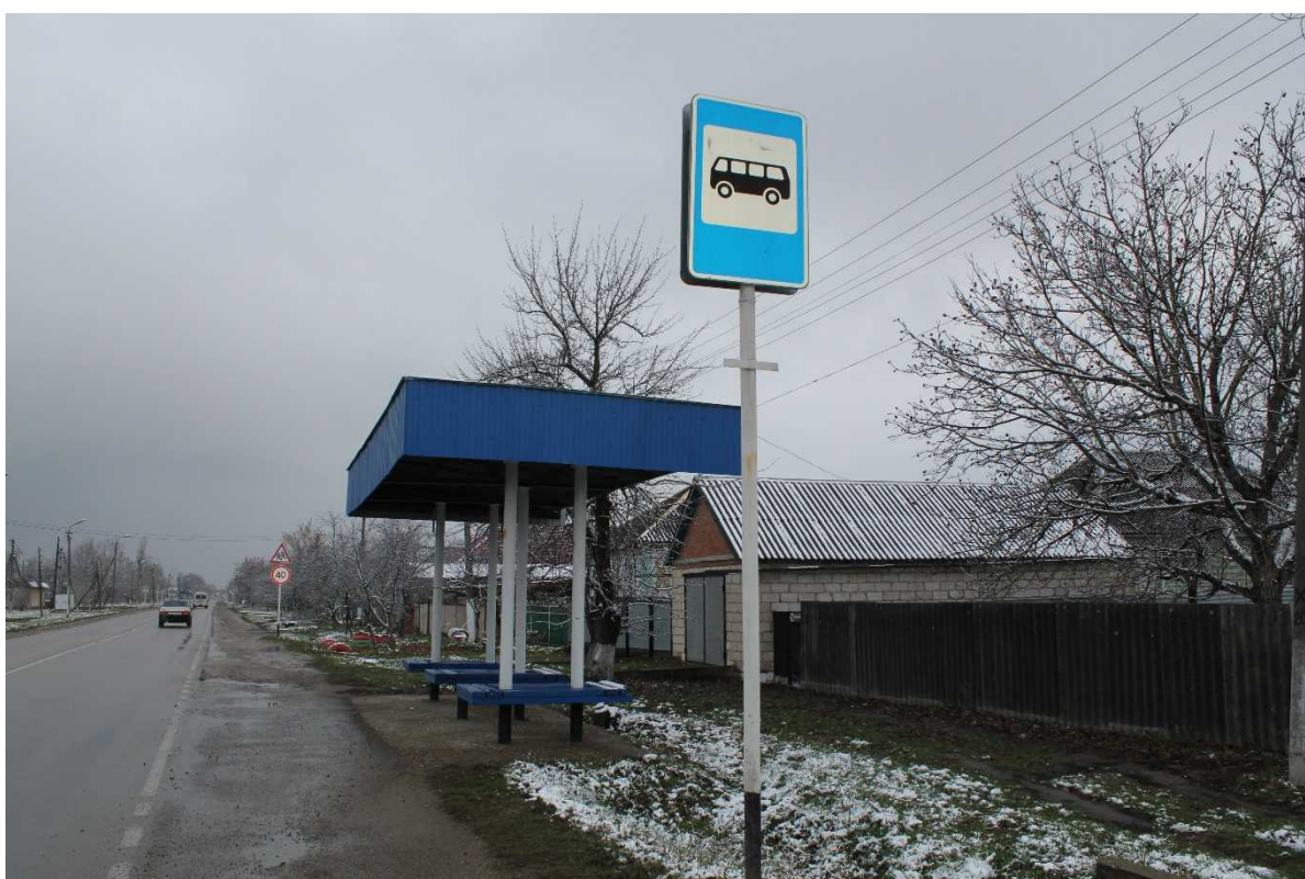
Внешний вид и состояние инфраструктуры остановки № 31
