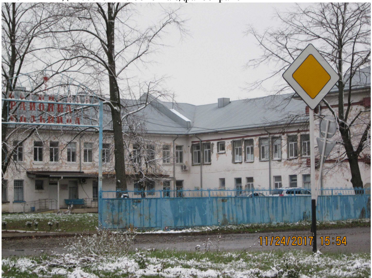
Внешний вид и состояние объекта здравоохранения
