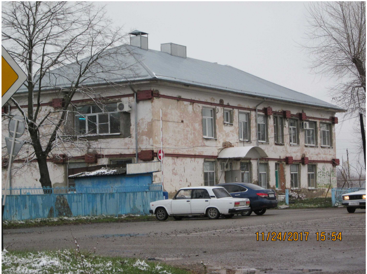
Внешний вид и состояние объекта здравоохранения
